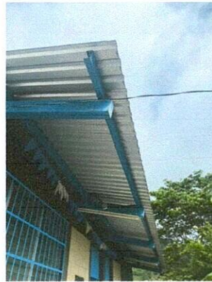
Foto 2: CANAL BAJADA DE AGUA PLUVIALES
